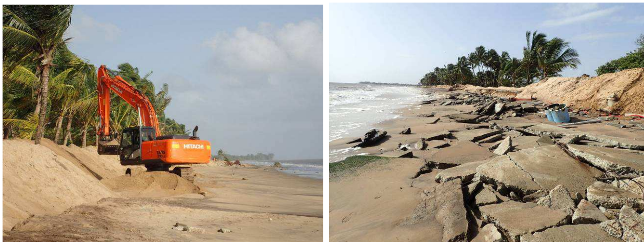
Figures 6 et 7 : Renforcement du talus le 5 mars 2016 et plaques de béton sur la plage (© Rachel Berzins).
